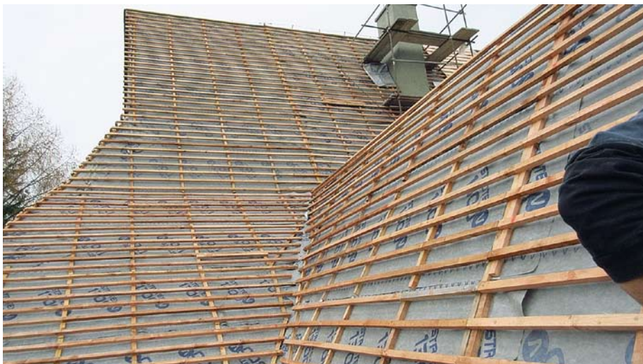
Zdokumentování odborného způsobu rozmístění latění pro dřevěný šindel. (Foto J. Polášek)
