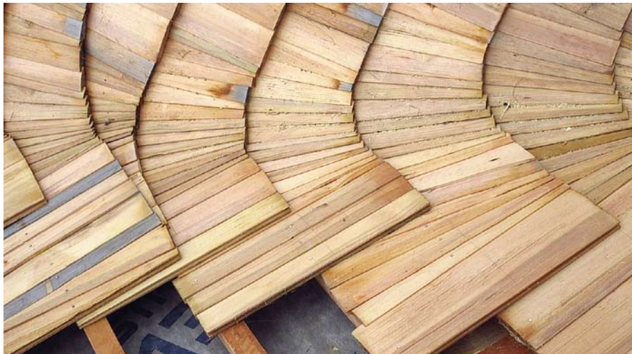
Odborné osazení úžlabin šindelů při montáži na střeše. (Foto J. Polášek)
