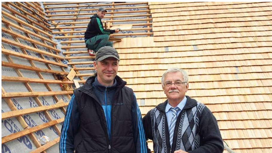
Kontrola montážních prací přímo na střeše budovy. (Foto J. Polášek)
